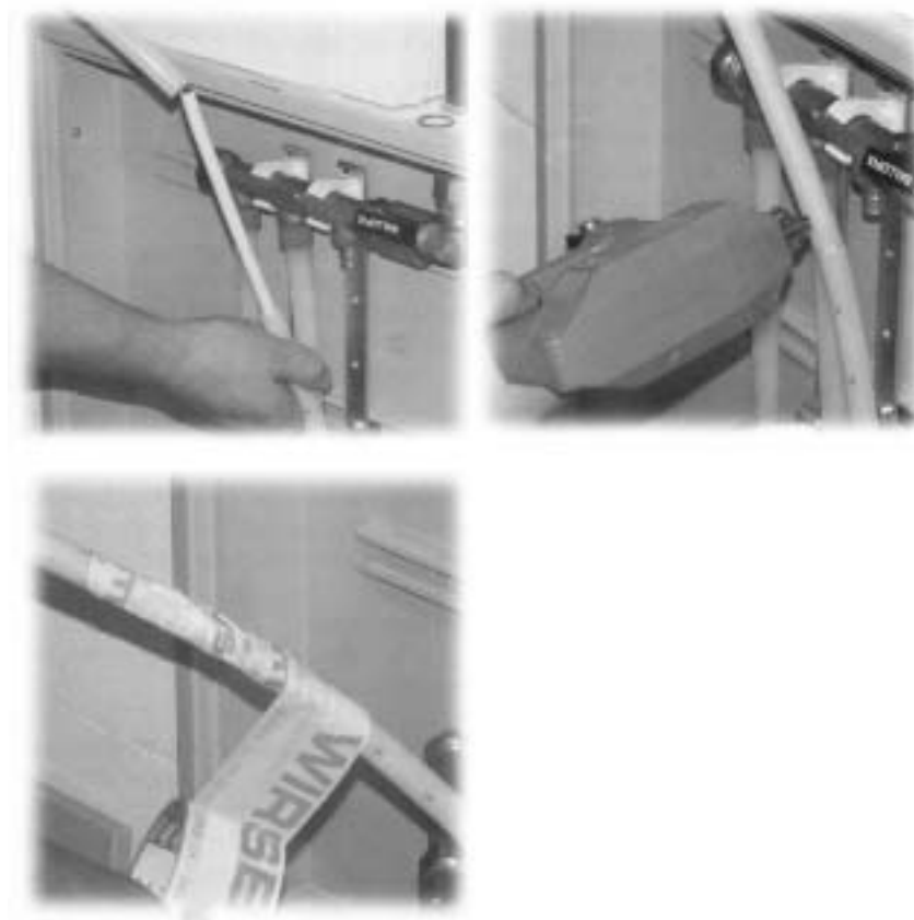
Рисунки 58-60: Замена поврежденной трубы
