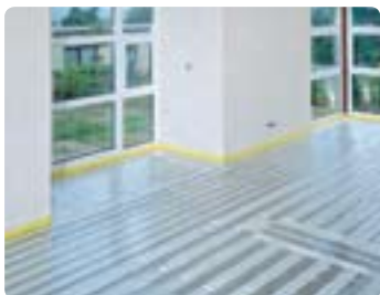
Легкие панели Upronog с теплораспределительными пластинами
